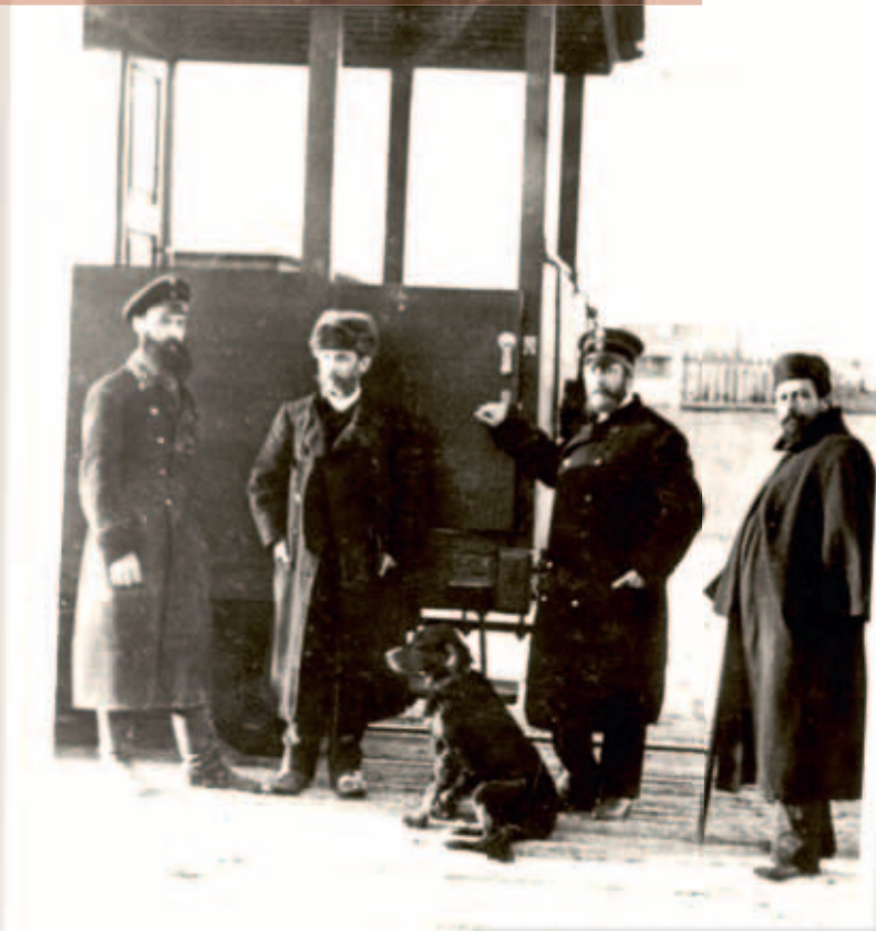
◀ П.Н. Фигнер (второй справа) на строительстве завода. 1896 г.
